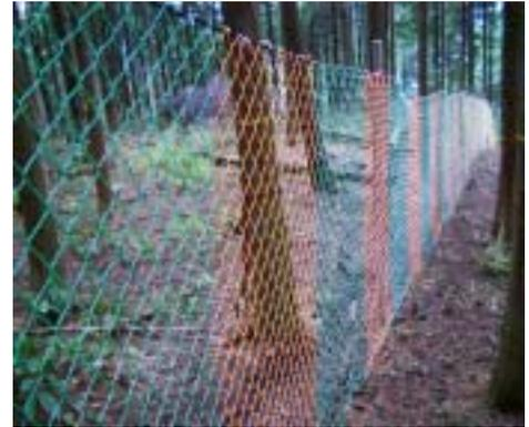
ダイニーマ®製獣害防止柵は、東洋紡績(株)と東工コーセン(株)が共同開発した新しいタイプのシカ柵です。柵のシカ等野生動物による切断を防ぐため、従来のシカ柵はスチール線を入れるのが常識でした。ダイニーマ®製獣害防止柵の最大の特徴は、このスチール線の代わりに超高強度繊維のダイニーマ®を採用しました。これにより、「**軽くて切れにくい**」商品が開発されました。
